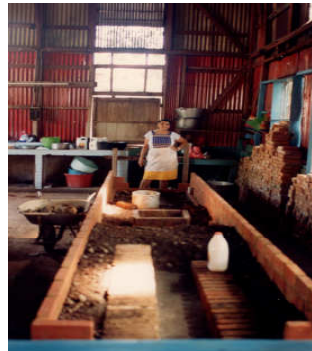
Foto 3. Construcción de la cocina eficiente
