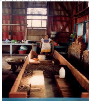
Foto 3. Construcción de la cocina eficiente
