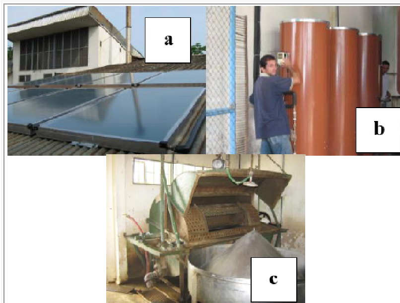
Figura 4. Módulo de Calentamiento de Agua: a) paneles solares; b) tanques de almacenamiento; c) mondonguera.
